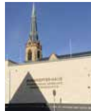
Johanneskirche Hauptstraße 35 68259 Mannheim Feudenheim
